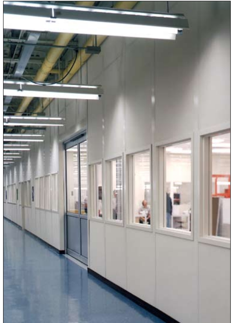
Recintos ambientales controlados para manufacturar componentes eléctricos. Puerta electrónica deslizante.
