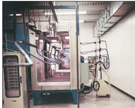
Cuarto de aplicación de capa de polvo.
