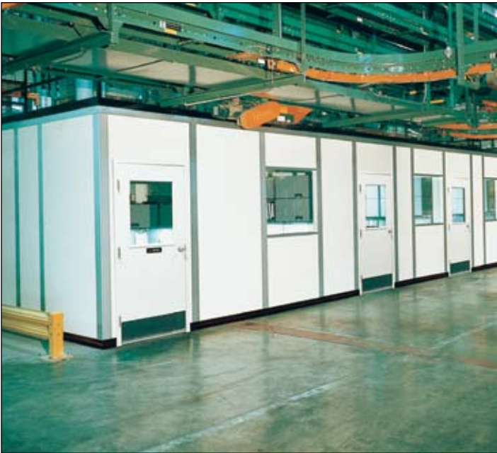
Oficinas de ingeniería y gerencia de Producción.
