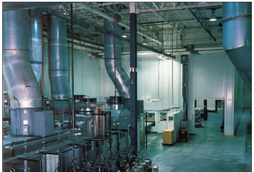
Sistema de acabados que permite control de temperatura, humedad y partículas.
