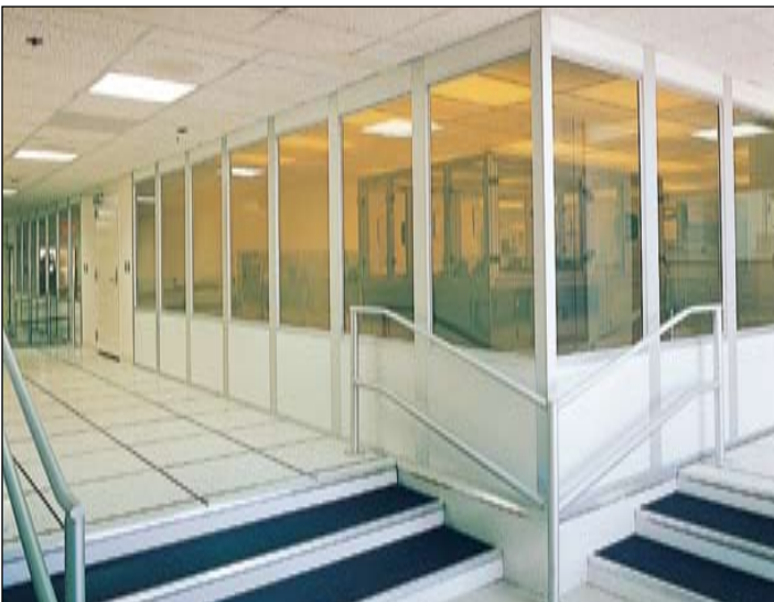
Cuarto limpio con pisos elevados en una planta de investigación y desarrollo.
