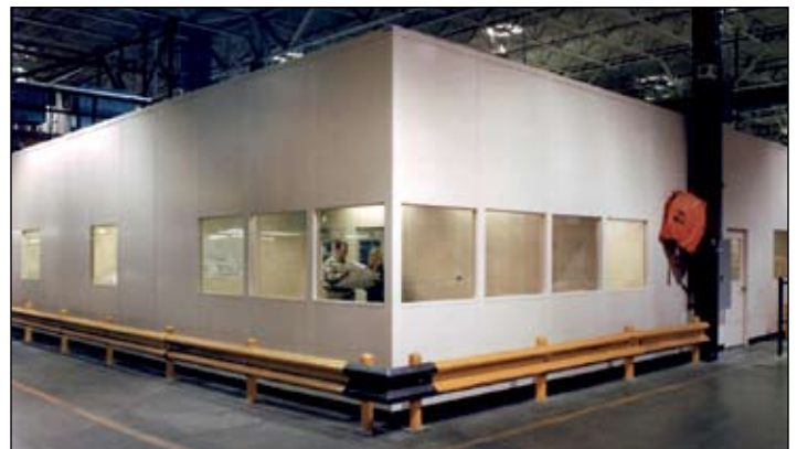
Complejo de oficinas con un barandal de protección.
