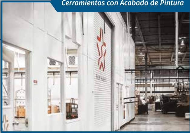
Cerramientos con Acabado de Pintura
