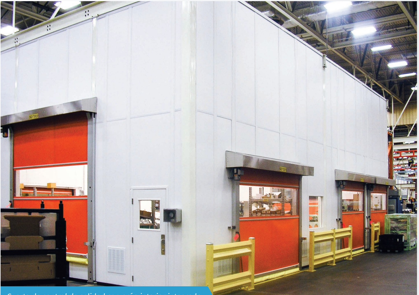
Cuarto de control de calidad con grúa interior integrada
