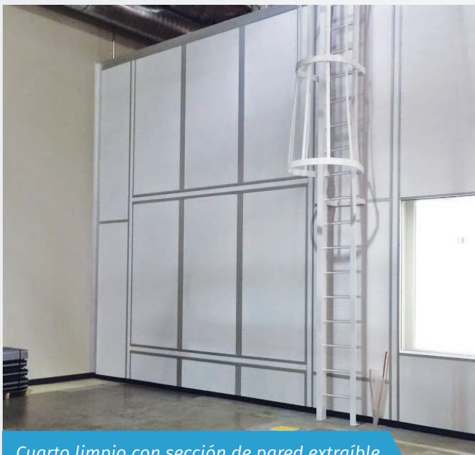
Cuarto limpio con sección de pared extraíble
