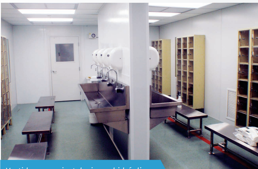
Vestidores con instalaciones hidráulicas
