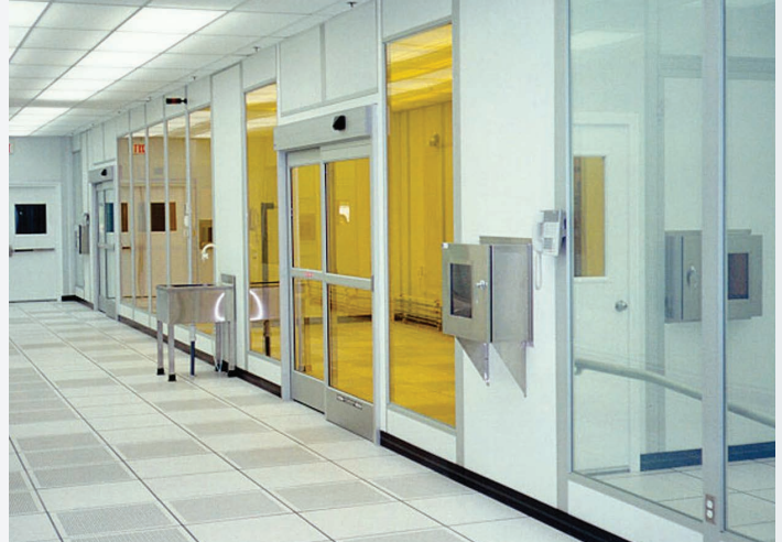
Cuarto limpio con puertas corredizas y cabinas de transferencia
