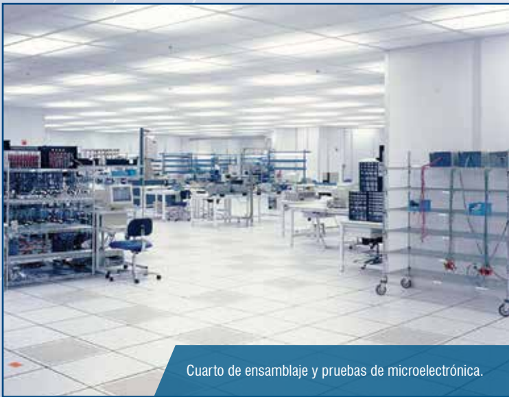
Las cubiertas de plénum con capacidad de carga proveen una plataforma de mantenimiento que elimina la necesidad de un paso de gato adicional.
