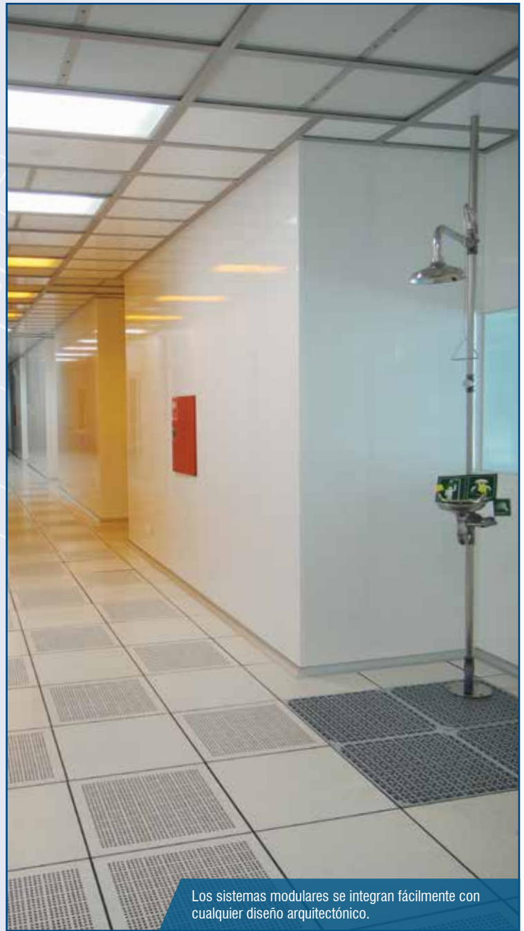
Las cubiertas de plénum con capacidad de carga proveen una plataforma de mantenimiento que elimina la necesidad de un paso de gato adicional.
